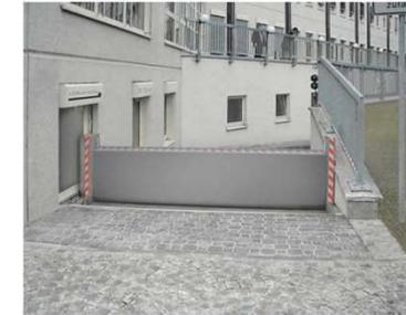
Klappschotte, aufschwimmend oder mit Antrieb
