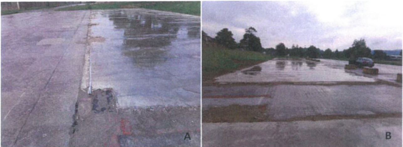
Abbildung 7: Abgebrochene Hallen 12, 13 und 15, (A und B: Blick auf Bodenplatte Halle 13 [Kraus 2018])
