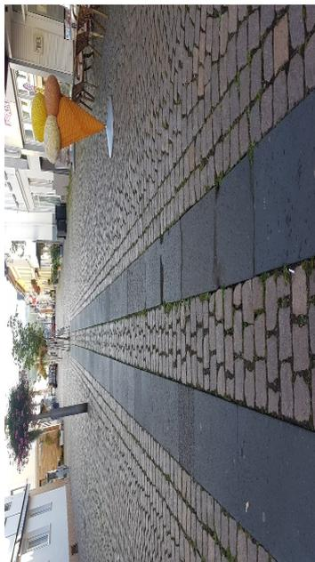
Die gewählte Ausführung wird der heutigen Verkehrsbelastung nicht mehr gerecht, so dass der gesamte in Längsrichtung verlaufende ca. 90 cm breite Streifen (Basaltplatten + Naturstreifen) Schäden aufweist und erneuert werden muss (s. MV 22/4164).
