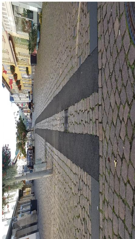
Auf Grundlage des Gutachtens ist es erforderlich, den Mittelstreifen auf der Gesamtlänge von 190 m zu erneuern. Die Ausführung sollte mit einem wasserdurchlässigen Beton und einem Haftkleber "frisch in frisch" hergestellt werden. Die Basaltplatten sind mit Fugen von 8 bis 15 mm zu verlegen. Alle 6,00 - 8,00 m ist eine durchgängige Dehnscheiben einzubauen (siehe Anlage Detailausführung Mittelstreifen).
