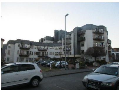
Abbildung 57: Altenzentrum in der Hochstraße (Quelle: WSW)
