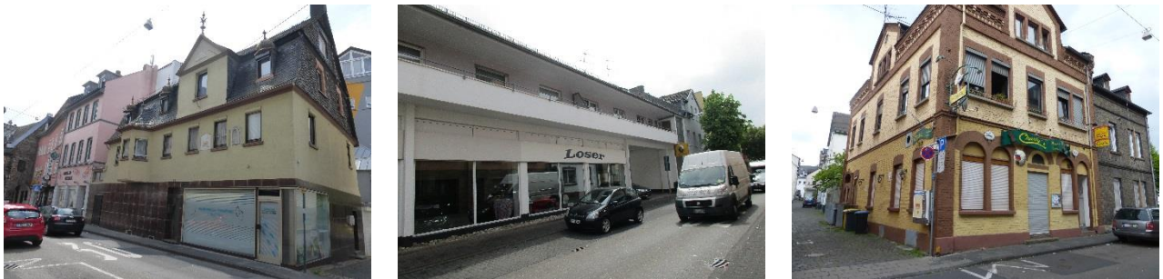
Abbildung 31: Gebäude mit Gestaltmängeln (Quelle: WSW)
