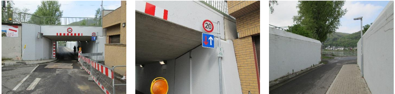
Abbildung 68: Unterführung an der Kirchstraße (Quelle: WSW)
