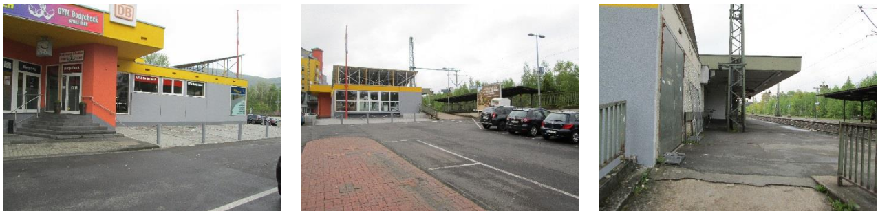
Abbildung 63: Bahnhof und Bahnsteig (Quelle: WSW)
