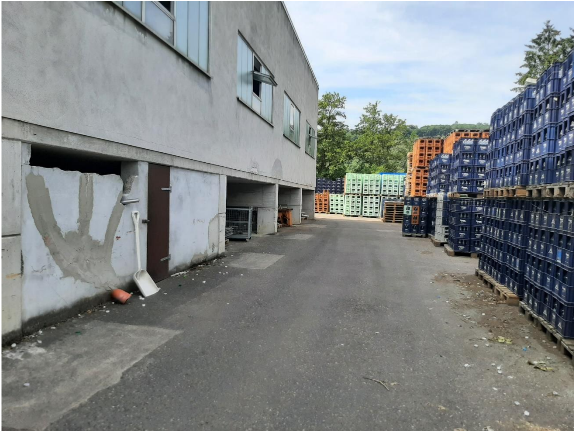
Abb. 10: Die mittlere Gewerbehalle, Blickrichtung Südwesten (eigene Aufnahme)
