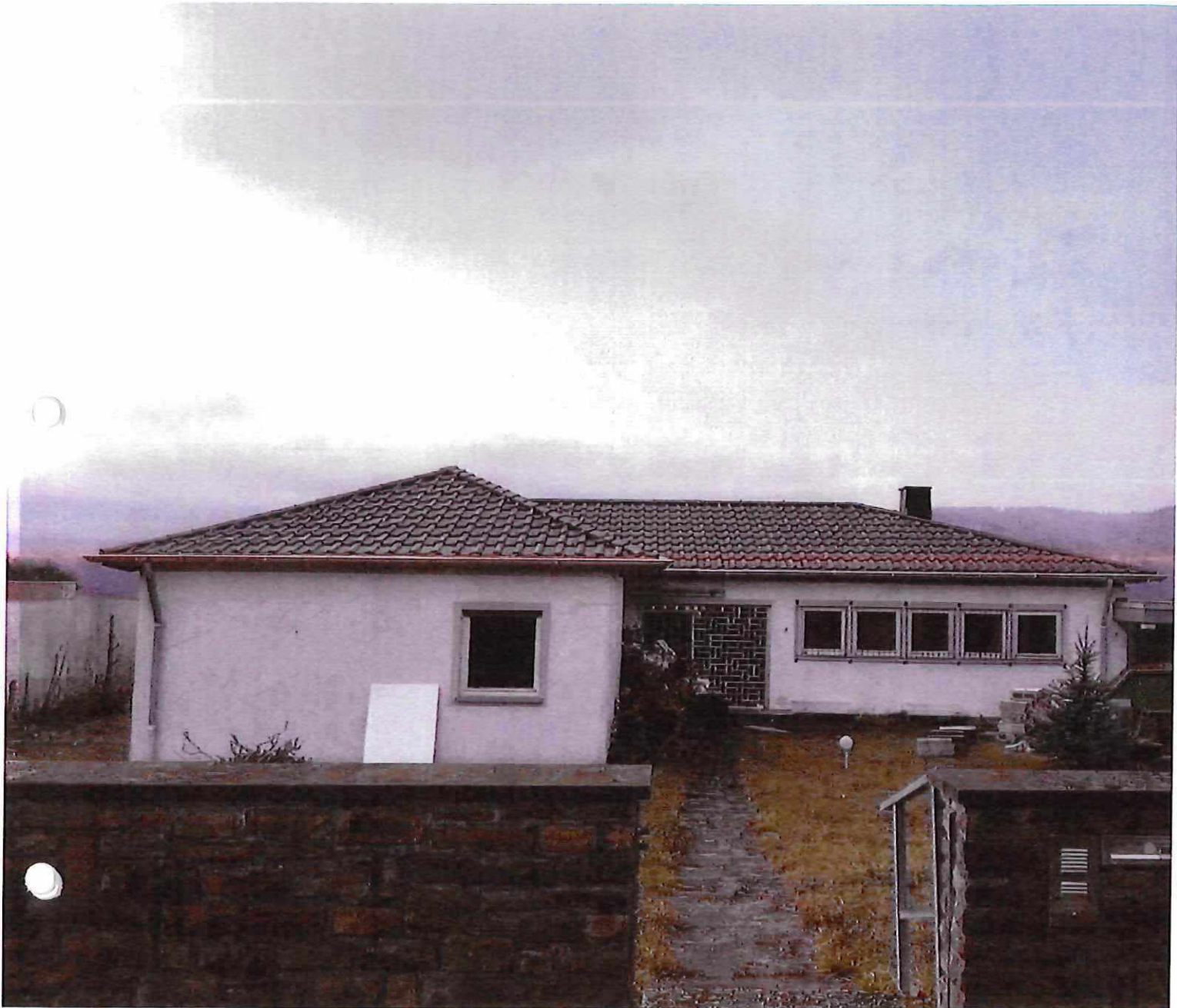
Neueindeckung mit Betondachsteine
