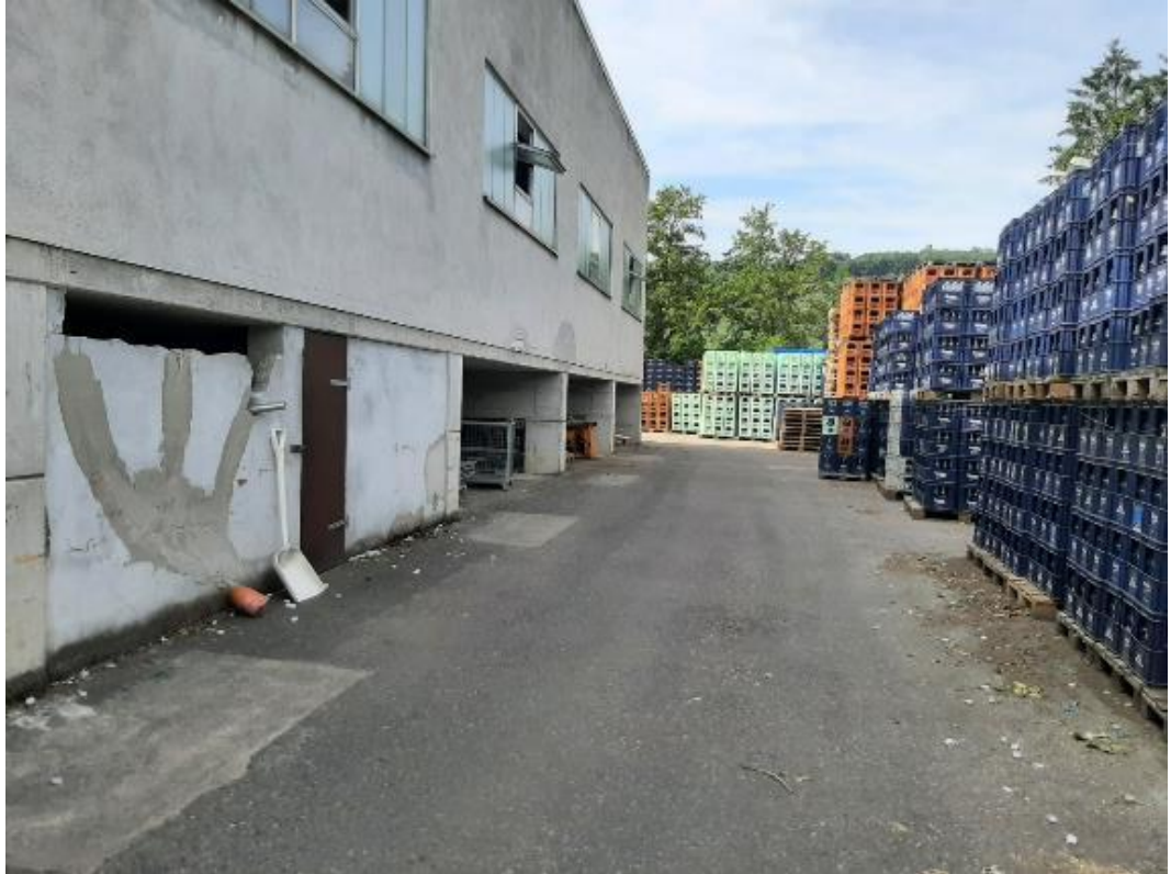
Abbildung 12 | Die mittlere Gewerbehalle, Blickrichtung Südwesten (Foto Planungsbüro Dittrich)
