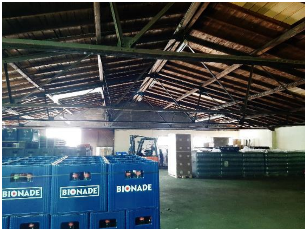
Abbildung 11 | Die südliche Gewerbehalle von innen (Foto Planungsbüro Dittrich)
