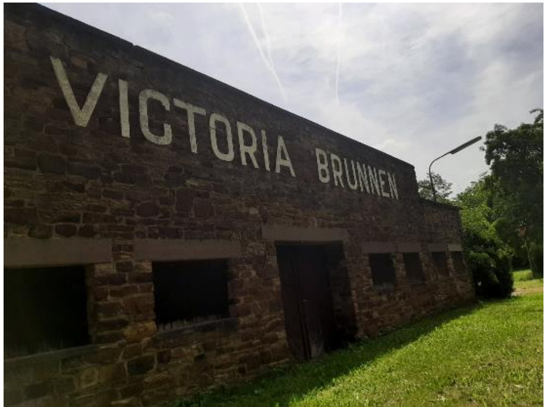
Abbildung 10 | Südwestl. Fassade der südlichen Gewerbehalle (Foto Planungsbüro Dittrich)
