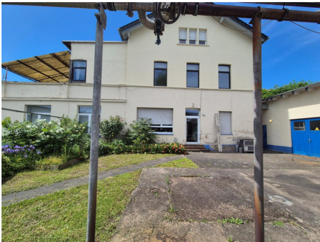
Abbildung 32 | Blick auf das Bürogebäude im Norden des Plangebiets; der Fundpunkt der Mauereidechse ist unten mittig
