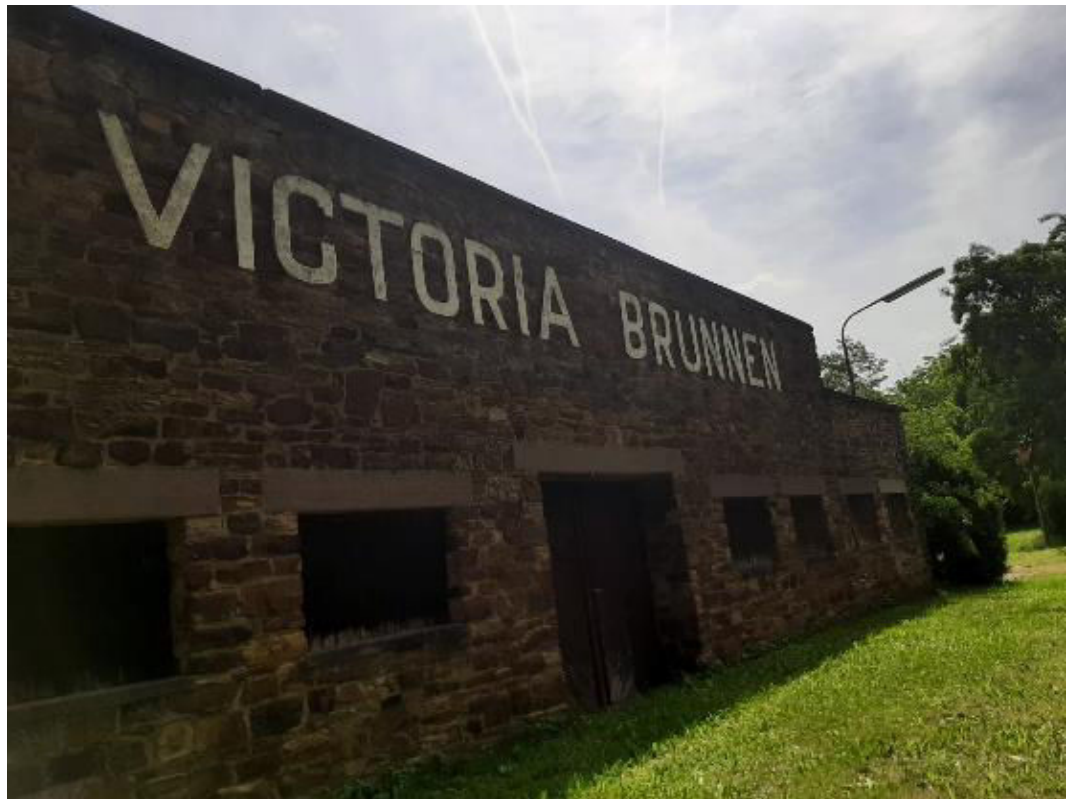
Abbildung 7 | Südwestl. Fassade der südlichen Gewerbehalle (Foto Planungsbüro Dittrich)
